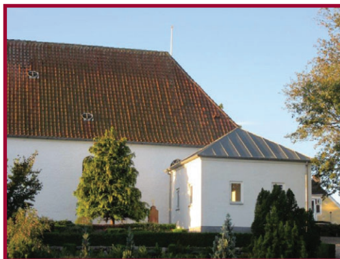
Tilbygning Gilleleje Kirke (2005)
